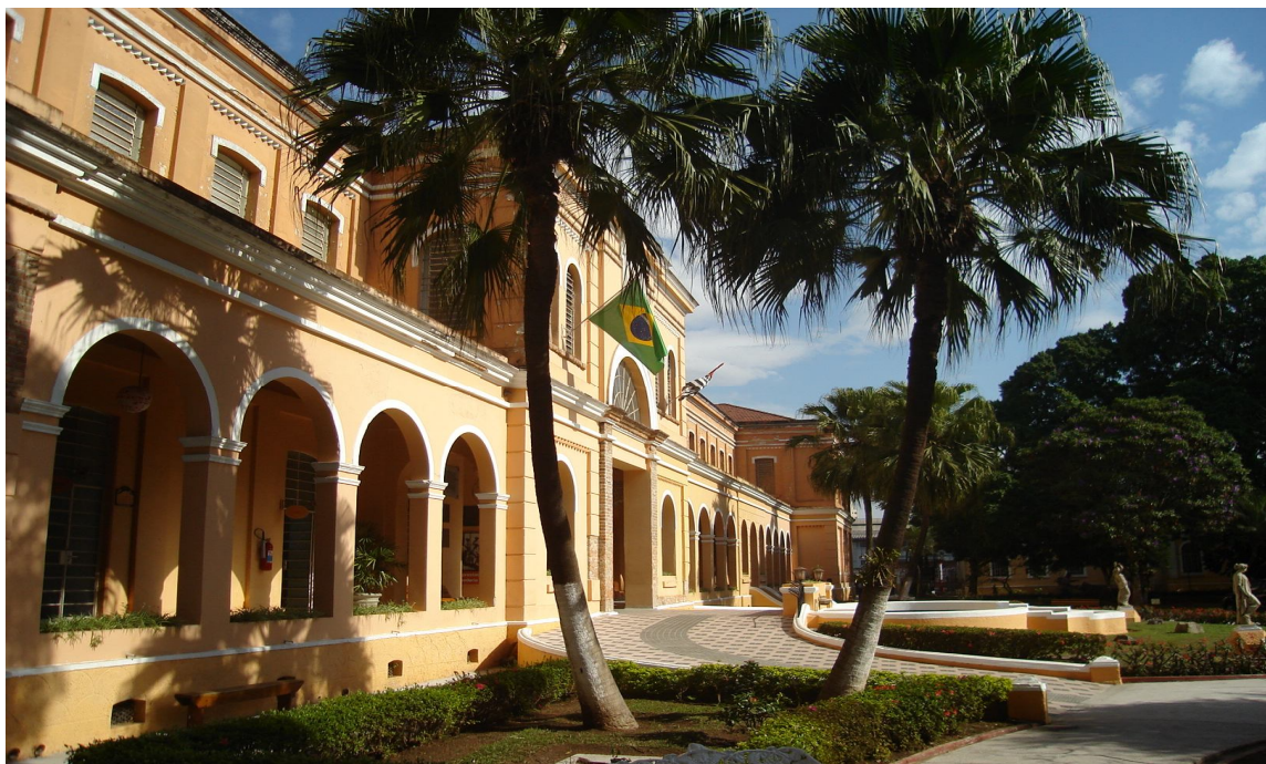
FOTO 2: Ilustração da fachada da antiga hospedaria dos imigrantes no Brás, atual Memorial do Imigrante. (Elaboração própria).
